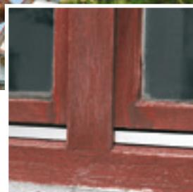
Die verwitterten Holzfenster wurden mit dem modernen, langlebigen **Aluminium-Verkleidungs-System von PORTAS** im Holzoptikt-Dessin „Eiche hell“ renoviert. Maßgenaue Aluminiumprofile werden von außen auf Rahmen und Flügel montiert.
