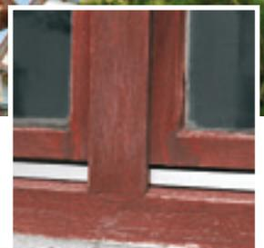
Die verwitterten Holzfenster wurden mit dem modernen, langlebigen **Aluminium-Verkleidungs-System von PORTAS** im Holzoptikt-Dessin „Eiche hell“ renoviert. Maßgenaue Aluminiumprofile werden von außen auf Rahmen und Flügel montiert.
